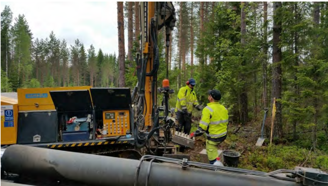
Kuva 3. Porakonekairauksista ja havaintoputkiasennuksista raskaalla Geomachine GM200 kairauskalustolla (Ramboll Oy). Kuva, Jari Hyvärinen, GTK
